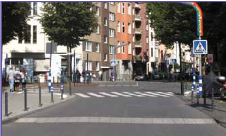
Beispiel für eine „Aufpflasterung“
