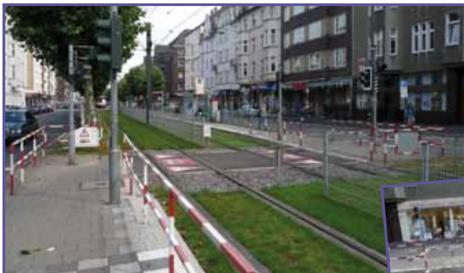
Gesicherter Bahnübergang mit Z-Führung, Wechselspringlichtern und Piktogrammen auf dem Boden
