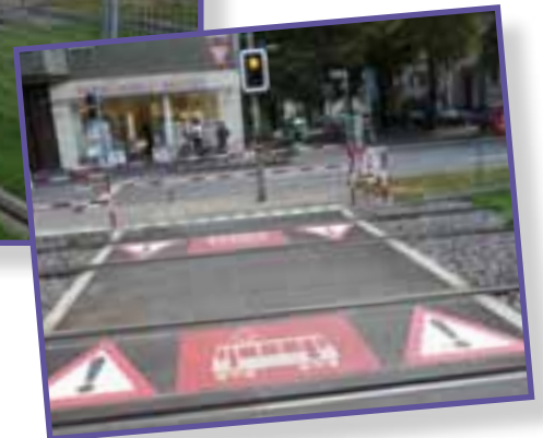
Gesicherter Bahnübergang mit Z-Führung, Wechselspringlichtern und Piktogrammen auf dem Boden
